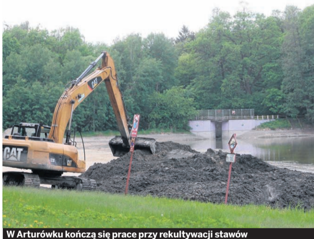
W Arturówku kończą się prace przy rekultywacji stawów
